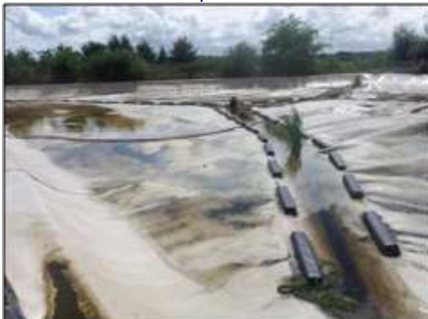
**Photo 21 : Exemple d'une couverture souple tendue de lagune**
