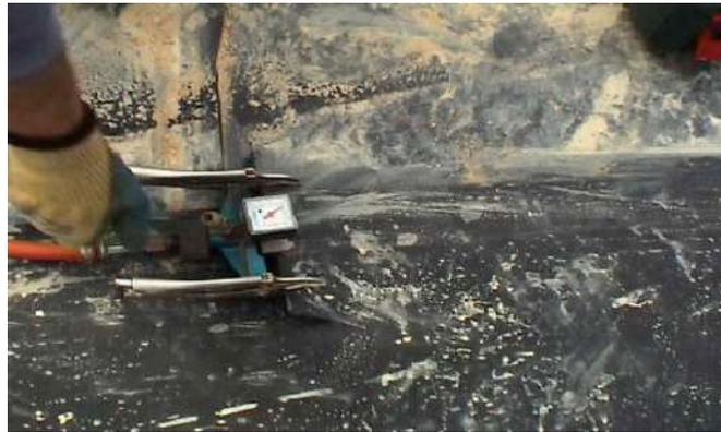
**Photo 23 : Contrôle de la pression du canal de la double soudure**
