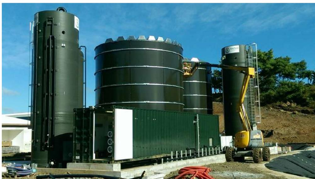
**Photo 18 : Exemple d'une zone technique de gestion et de traitement des lixiviats– Cuves acier vitrifiées BIO + UF + NF**
